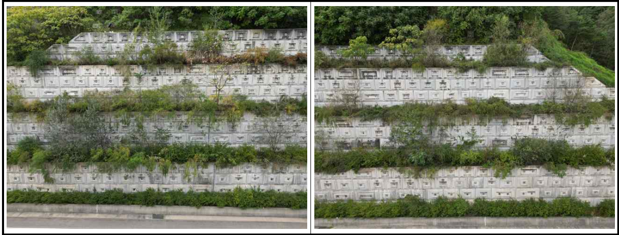
【사진 5.3.2】전면부 전경
