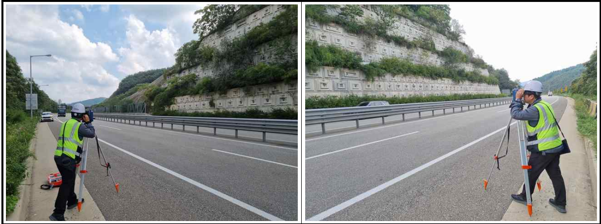
【사진 5.4.2】 측량작업 전경
