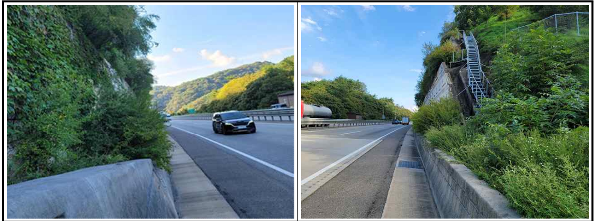
【사진 5.3.1】 지반, 기초부 전경
