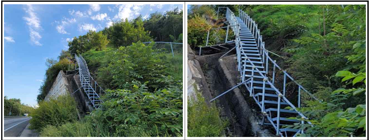
【사진 5.3.4】 옹벽 점검시설 전경
