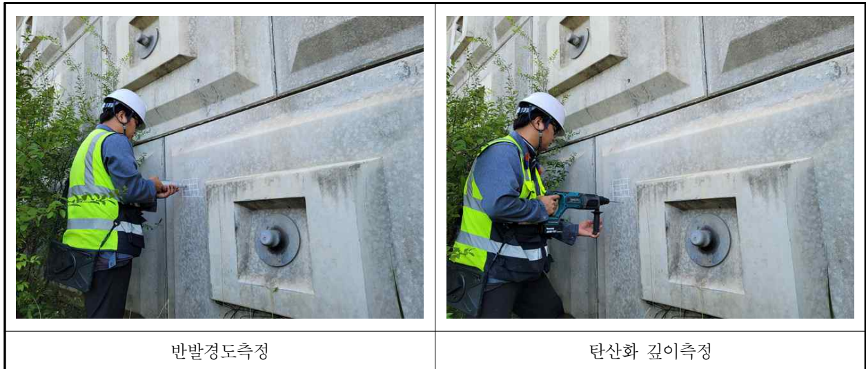
【사진 5.4.1】 재료시험 조사 전경
